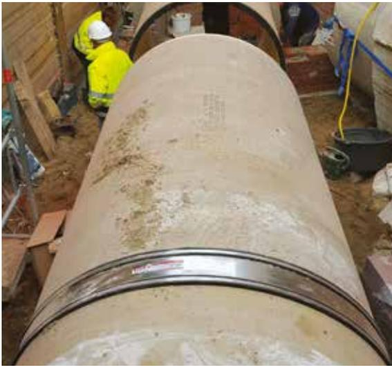
**Manschetten mit großem Durchmesser werden als Spezialanfertigungen auf Bestellung nach Kundenangaben hergestellt. Sie können für praktisch jeden Rohrdurchmesser angefertigt werden. Jede gewünschte Kupplungs-Sondergröße kann innerhalb von 24 - 48 Stunden vor Ort angeliefert werden.**
